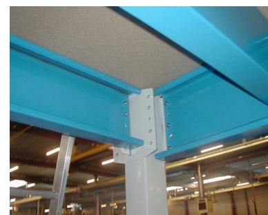
Assemblage poteau / lisse
